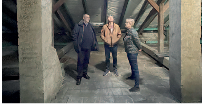
A helyszíni bejárás a tetőtérben kezdődött.
